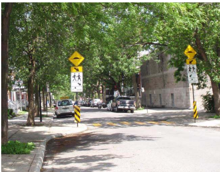
Passage piéton surélevé et non protégé aux abords de l'école Notre-du-Perpétuel-Secours – arrondissement Le Sud-Ouest
