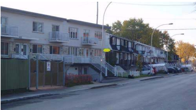
Présence de nombreuses entrées charretières sur la rue Villeneuve – arrondissement de Montréal-Nord
