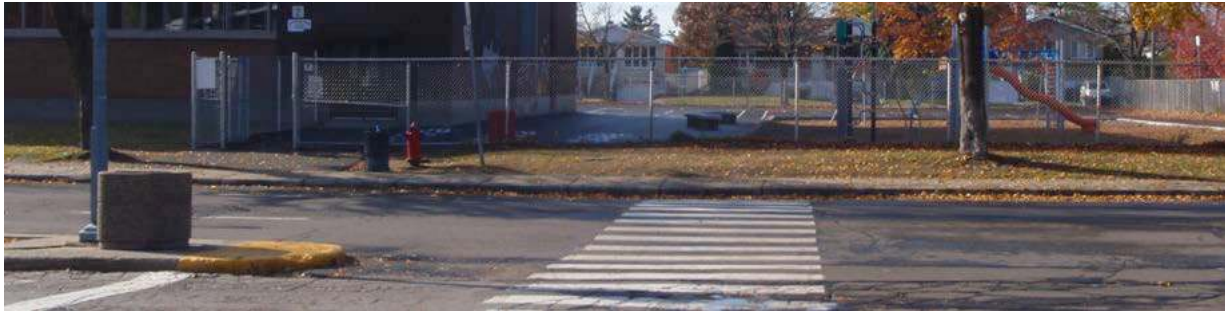
Absence de bateau pavé vis-à-vis du passage piéton à l'intersection des boulevards Ste-Colette et Maurice-Duplessis
