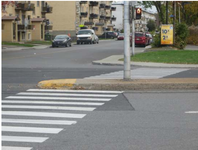
En l'absence de bateau pavé, les piétons à mobilité réduite doivent contourner l'îlot refuge – Intersection des boulevards Léger et Rolland
