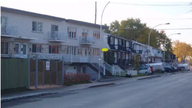
Présence de nombreuses entrées charretières sur la rue Villeneuve – arrondissement de Montréal-Nord
