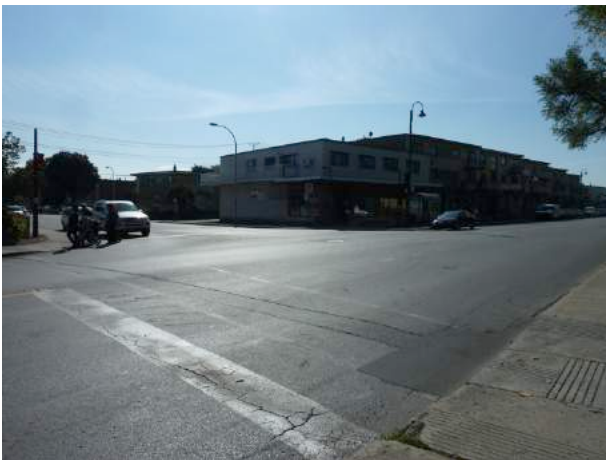
Passages piétons effacés – Intersection de la rue Jean-Talon Est et du boulevard de l'Assomption
