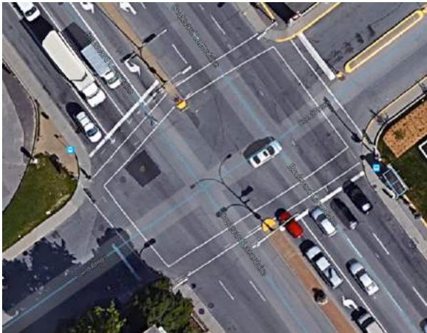
Intersection du boulevard Lacordaire et de la rue d'Amos – arrondissement de Montréal-Nord
