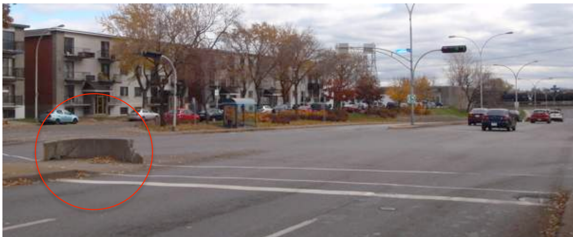
Présence d'un ilot refuge d'environ 4,5 m de large à l'intersection des boulevards Lacordaire et Industriel
