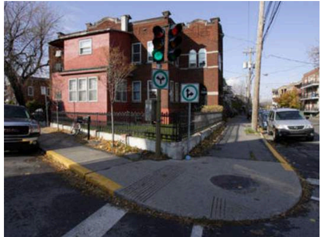
Exemple de marquage visant le dégagement visuel de l'intersection – arrondissement de Verdun
