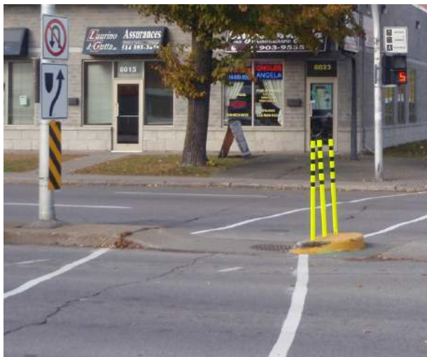
Îlot refuge n'offrant que peu de marge de recul par rapport au trafic motorisé – Intersection de l'avenue Désy et du boulevard Henri-Bourassa
