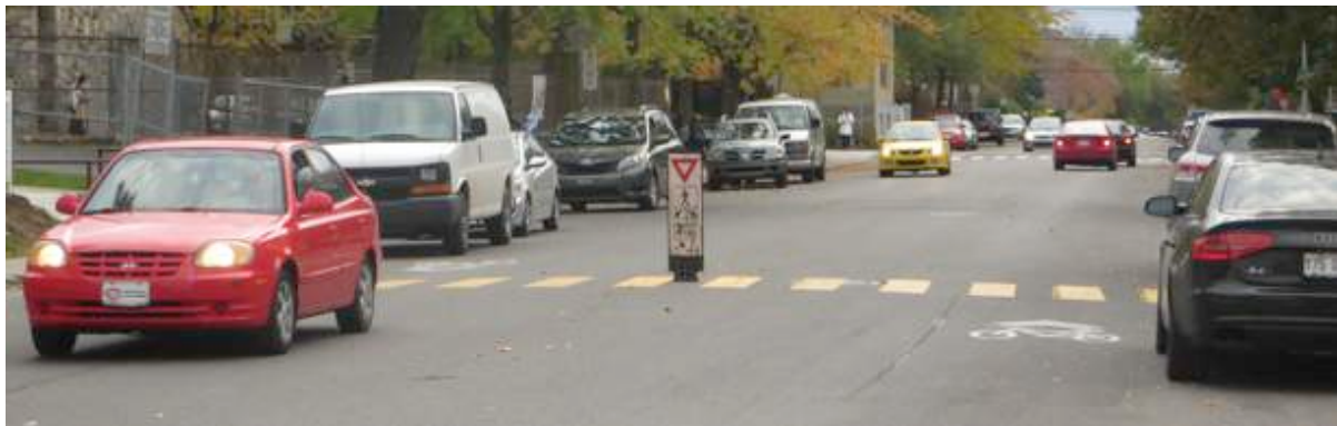
Combinaison d'une balise centrale et d'un passage piéton non protégé – arrondissement de Montréal-Nord
