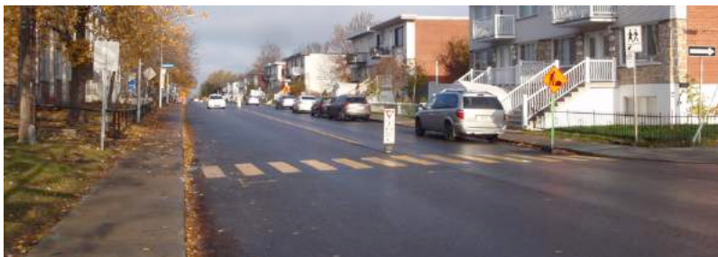
Boulevard Rolland – arrondissement de Montréal-Nord
