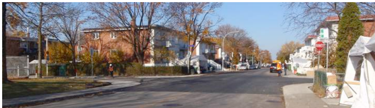
L'intersection du boulevard Rolland et de l'avenue de Dijon est surélevée
