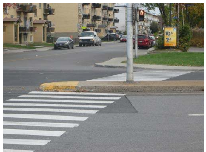
Terreplein jouant le rôle d'un îlot refuge, mais ne bénéficiant pas de bateau pavé – Intersection des boulevards Léger et Rolland
