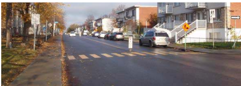
Boulevard Rolland – arrondissement de Montréal-Nord
