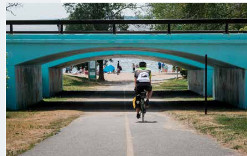
Les tunnels larges favorisent l'éclairage naturel et minimisent le sentiment de confinement. Tunnel pour sentier polyvalent sous la promenade Sir-John-A.-Macdonald, Ottawa
