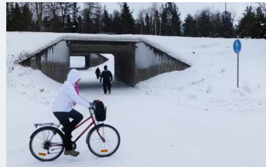
Tunnel sous la route Tulliväylä, Oulu, Finlande
