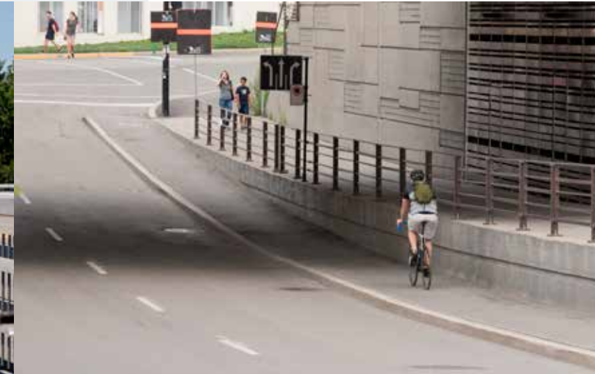
Trottoir large et piste cyclable surélevée, Boulevard Décarie, Montréal
