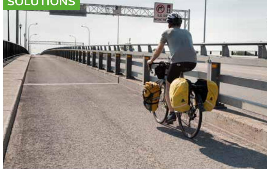
Piste cyclable et trottoir sur le pont Viau, Montréal
