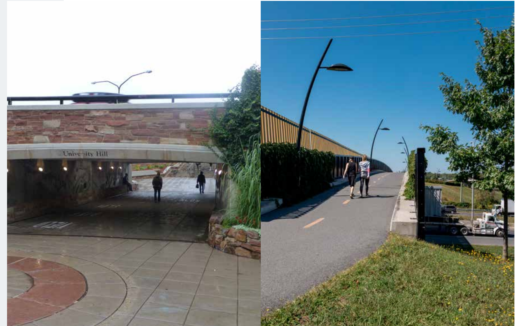
Tunnel pour piétons et cyclistes sous la route 93, Boulder, Colorado
