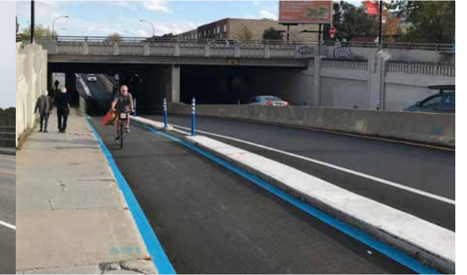
Trottoir large et piste cyclable du Réseau express vélo séparée physiquement de la voie de circulation routière par une bordure de béton, rue Saint-Denis, Montréal
