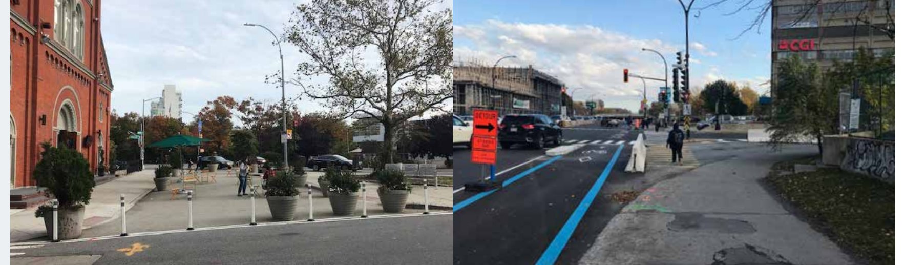
Fermeture de la voie de raccordement à l'aide de jardinières et de bollards, Brooklyn, New York
