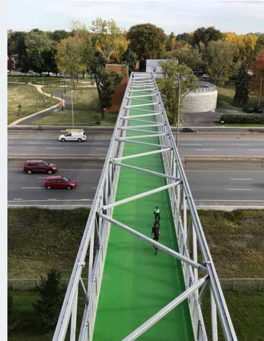
Passerelle pour piétons et cyclistes au-dessus de la route 132 à Longueuil
