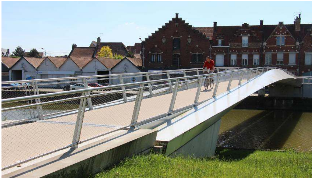
Passerelle cyclable franchissant un cours d'eau ; Saint-Omer (France)
