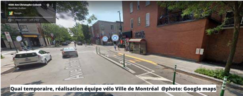
Bordure en béton ancrée @photo: Équipe Vélo Ville de Montréal
