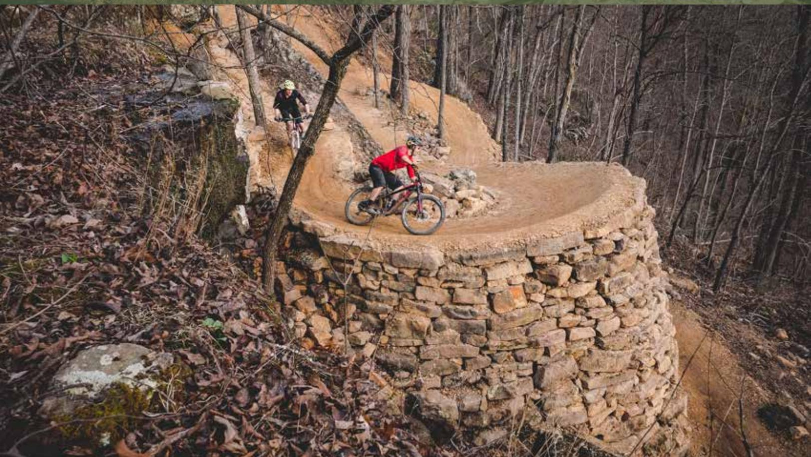
L'aménagement d'un mur de soutènement extrême a été nécessaire pour construire le sentier le long d'une falaise. Photo : Hansi Johnson
