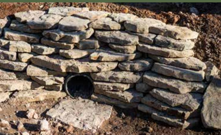
Petit mur de soutènement avec ponceau. Photo : Eli Glesmann/Rock Solid
