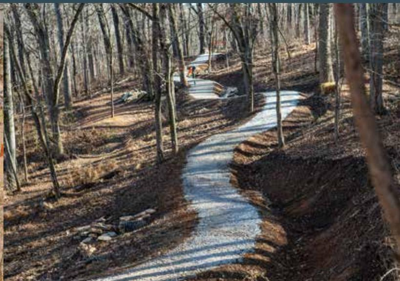
*Piste de montée en enduit superficiel prête à recevoir les couches de finition d'asphalte liquide et d'agrégats fins de la Coler Mountain Bike Preserve à Bentonville, en Arkansas. Photo : Eli Glesmann/Rock Solid*
