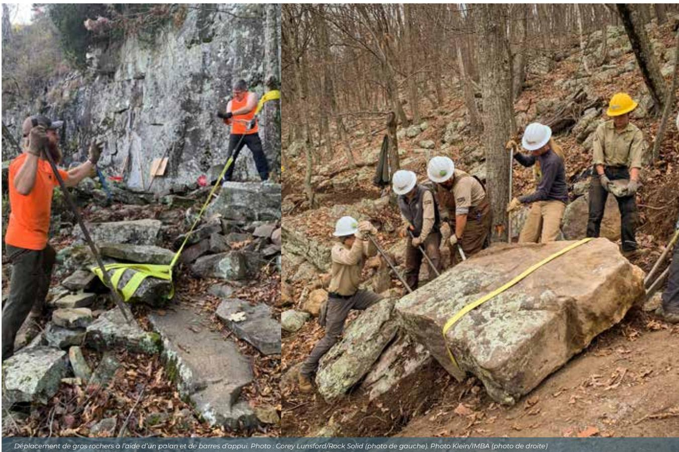
Déplacement de gros rochers à l'aide d'un palan et de barres d'appui. Photo : Corey Lunsford/Rock Solid (photo de gauche), Photo Klein/IMBA (photo de droite)
