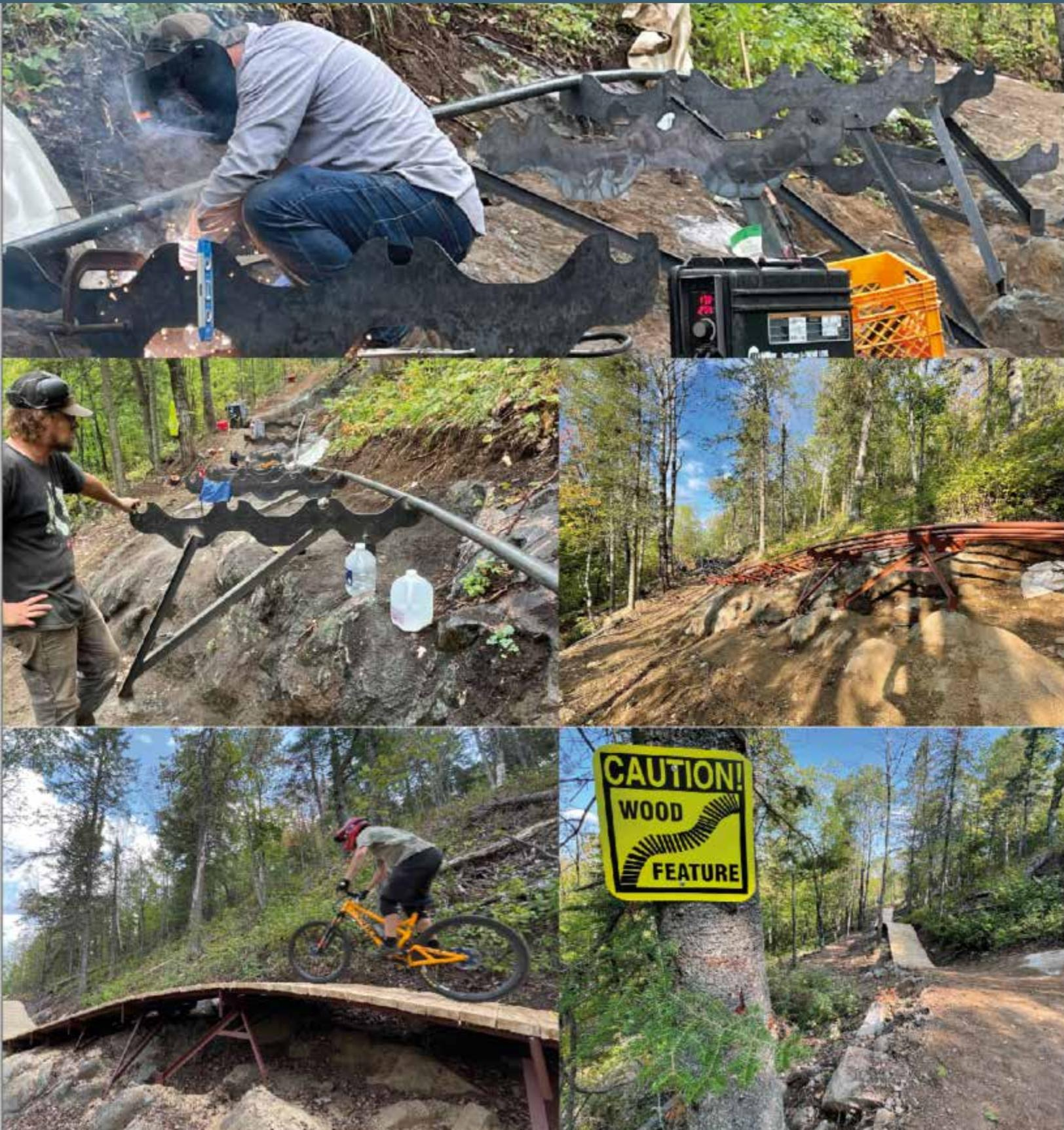
Passerelle en acier faite sur mesure avec table en bois à Giants Ridge à Biwabik, au Minnesota. Photos par Adam Buck/Pathfinder Trail Building
