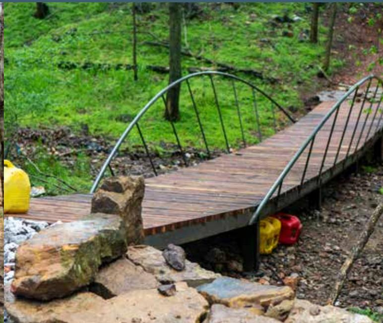
Pont à structure métallique avec table en bois entre Headstart et Slaughter Pen à Bentonville, en Arkansas. Photo : Eli Glesmann/Rock Solid
