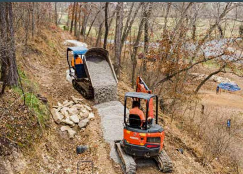
*Piste de montée en enduit superficiel en construction de la Coler Mountain Bike Preserve à Bentonville, en Arkansas. Photo : Eli Glesmann/Rock Solid*
