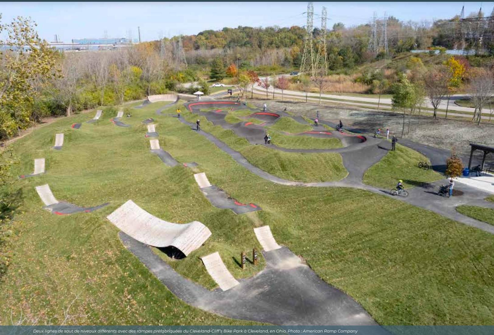
Deux lignes de saut de niveaux différents avec des rampes préfabriquées du Cleveland-Cliff's Bike Park à Cleveland, en Ohio. Photo : American Ramp Company
