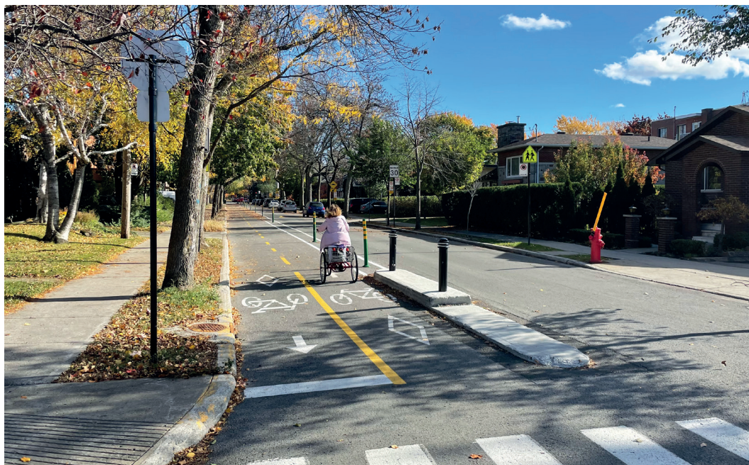
Figure 18 Piste cyclable, îlot de béton et délinéateurs, rue Sagard, Montréal
