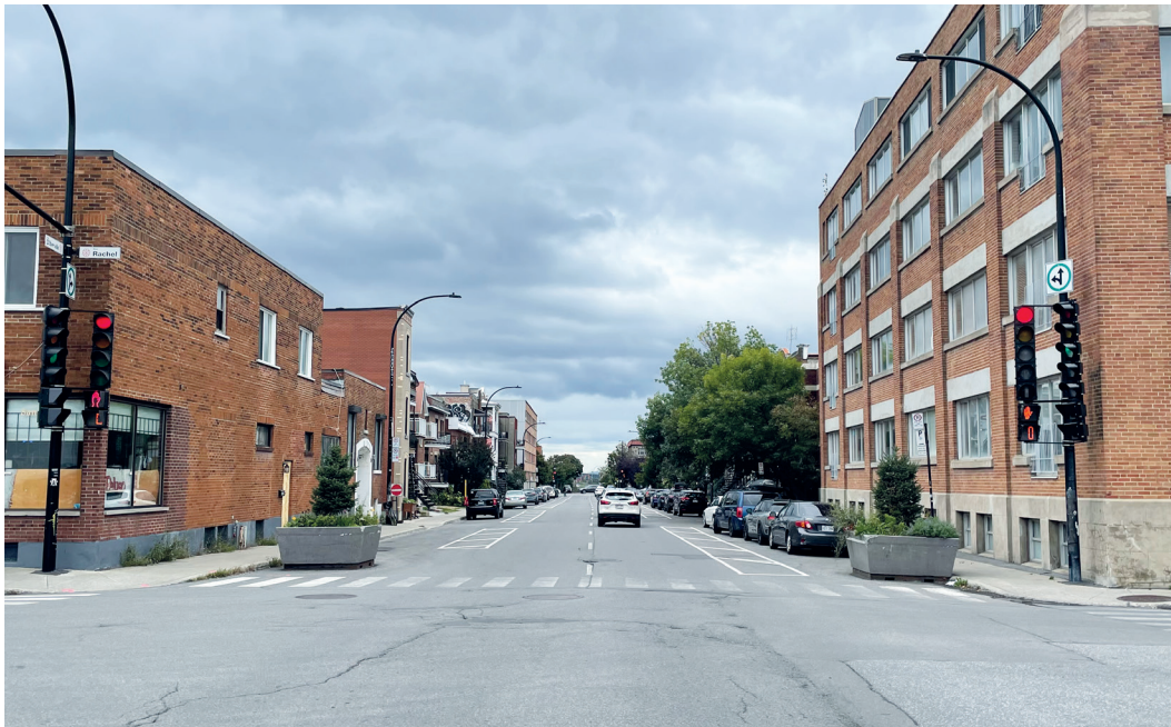
Figure 34 Zone tampon, rue d'Iberville, Montréal
