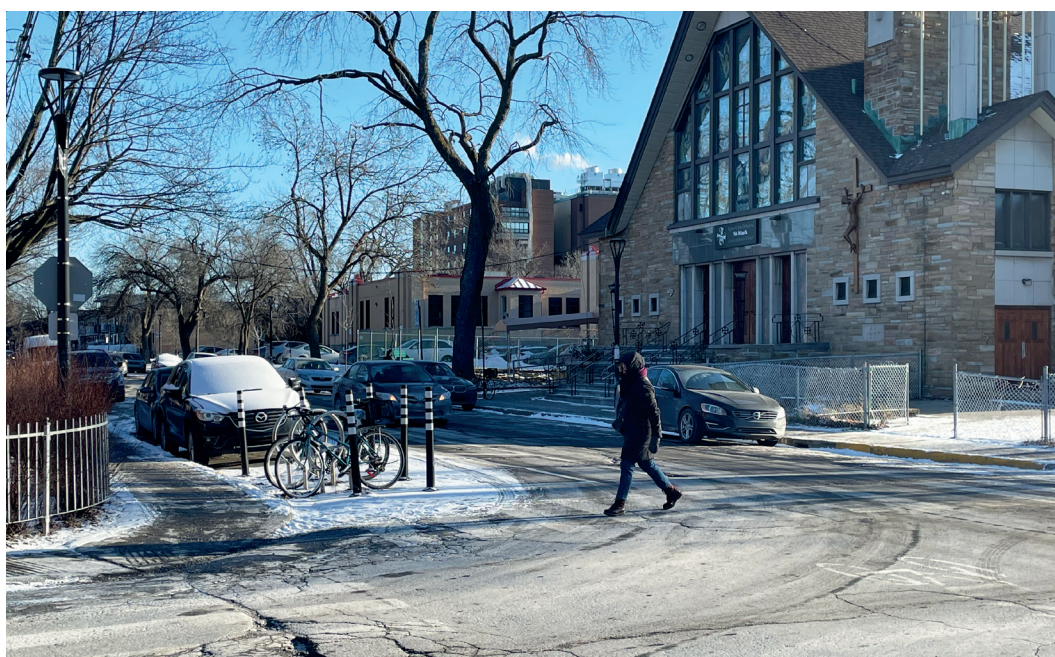
Figure 39 Saillie de trottoir transitoire entretenue en hiver, rue Fabre, Montréal
