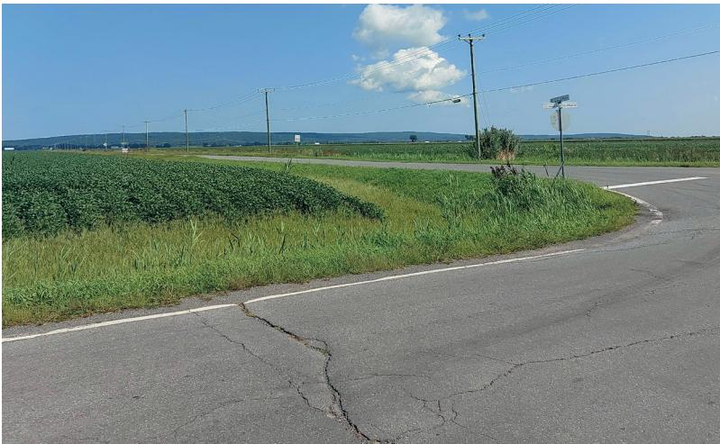
**MAUVAISE** : Qualifie une chaussée très dégradée qui nuit au contrôle du vélo et expose les cyclistes à des risques évidents (chute, enlisement, perte de contrôle). Ex. :
